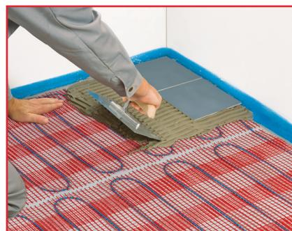
Fleksibilno ljepilo nanesite izravno na grijaću mrežu po čitavoj njezinu površini te ga prema uputama ostavite da se suši. Nakon toga nanesite drugi sloj fleksibilnog ljepila za lijepljenje pločica. Zatim postavite pločice.
